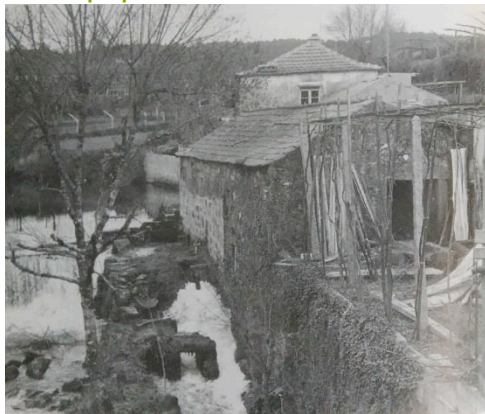
Figura 51 - Serração associada à moagem e casa do proprietário - S Martinho do Coura
