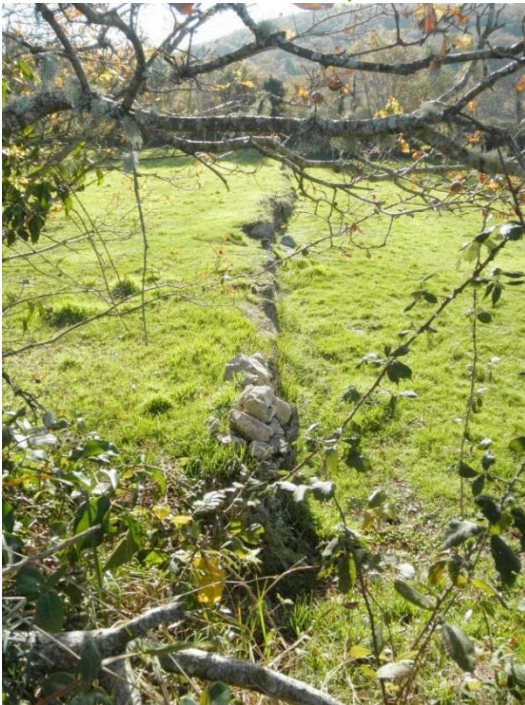
Foto 62 - Muros de suporte
