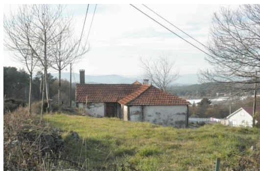
Foto 37 - Casa de Lavoura, em Castanheira
